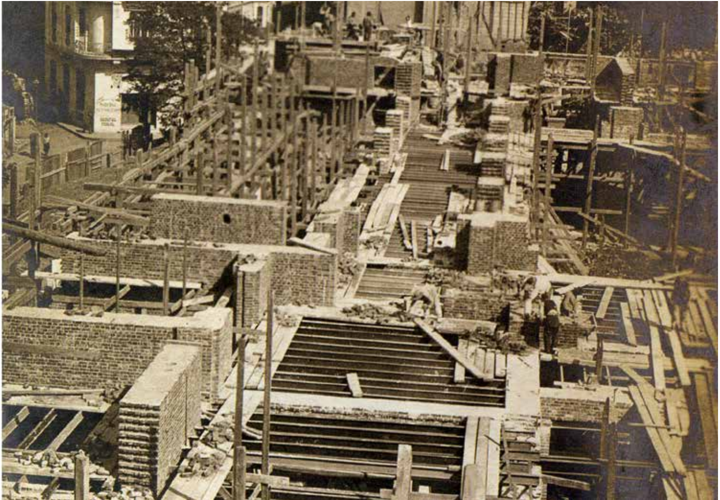
Büyük Postane inşaatı.
