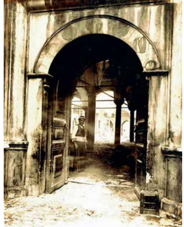
Hamîd-i Evvel İmâretî'nin yıkım aşaması
